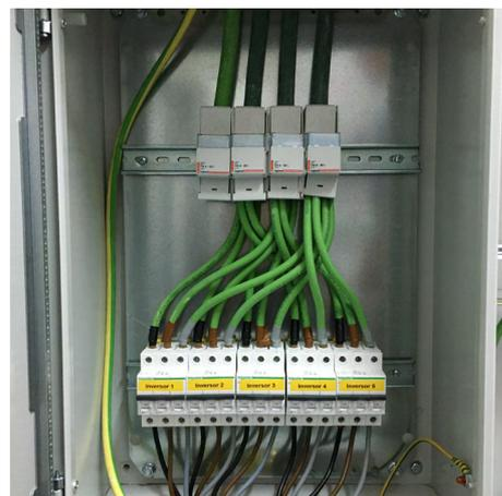
Gracias a la empresa Fronius System Partner, **Imsegra**, encargada de llevar a cabo este Revamping, que ha consistido en la sustitución de un inversor obsoleto de 110 kW por 5 inversores **Fronius Symo 20 kW**, se ha logrado que este sistema de 117,6 kWp, ubicado en la cubierta de un edificio de oficinas, sea más rentable y funcional que nunca para seguir satisfactoriamente con su actividad de venta de energía.
